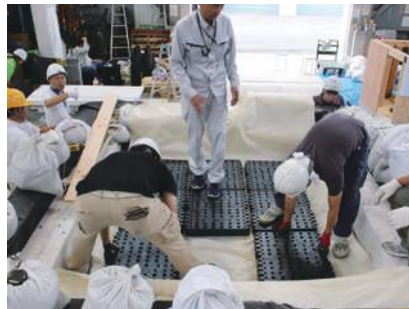
スーパージオ®SG70施工
