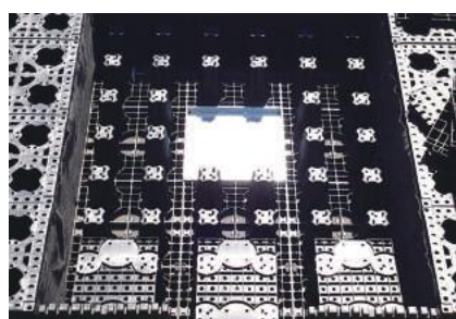
4 点検孔(土砂捕捉水透過壁)
