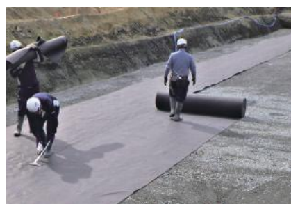
1 保護シート敷設
